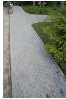
Budowa chodnika do przedszkola w Sulęcynie
