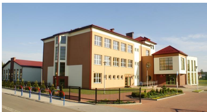
Budowa szkoły podstawowej oraz ulicy Szkolnej w Sulęczyńno
