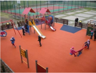
Budowa szkolnego placu zabaw przy SP w Sulęczynie w ramach rządowego programu „Radosna szkoła”
