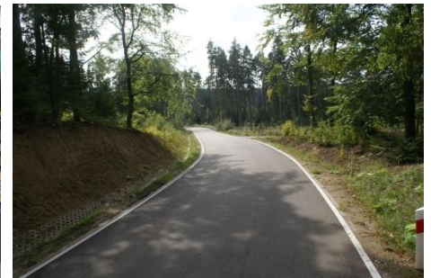
Modernizacja drogi Bukowa Góra – Sulęczyno II etap
