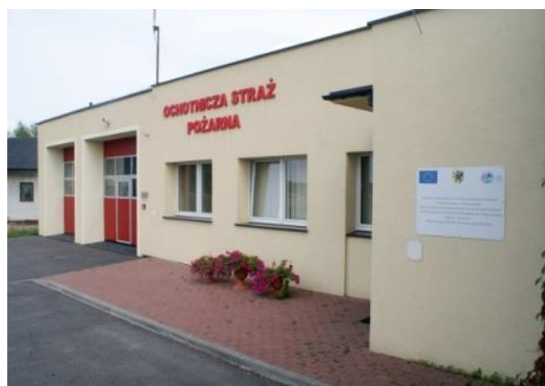
Rozbudowa i przebudowa świetlicy wiejskiej w budynku remizy OSP w Kistowie
